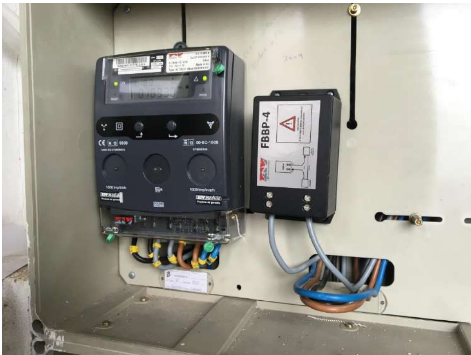
Figura 49. Instalación de un filtro ZIV con conexión de fase.
