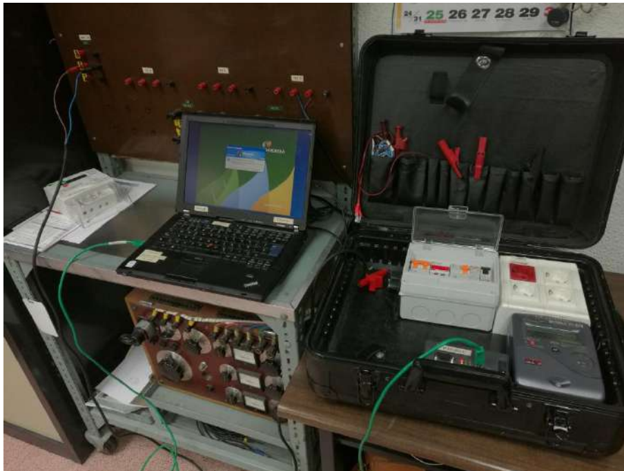
Figura 62. Equipamiento de Iberdrola utilizado para realizar las pruebas con los filtros (I).
